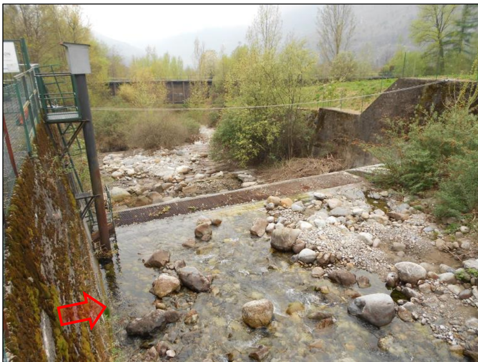
Figura 21: tratto interessato dallo scarico di restituzione delle acque al torrente Remulo dell'impianto in progetto.
