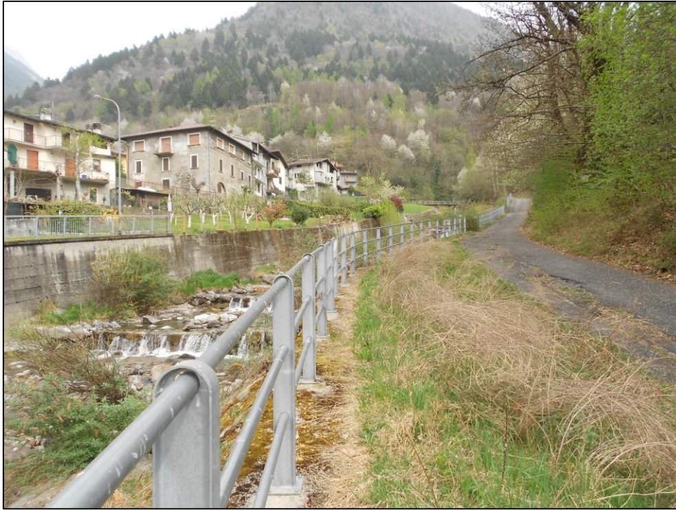
Figura 13: Tratto di posa della condotta forzata al di sotto del piano stradale della viabilità comunale esistente.
