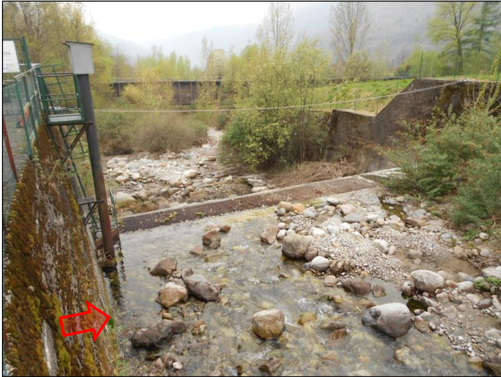
Figura 2: tratto interessato dallo scarico di restituzione delle acque al torrente Remulo dell'impianto in progetto.
