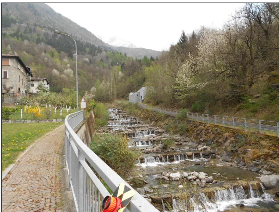
Figura 4: tratto del torrente Remulo interessato dalla realizzazione dell'opera di presa.
