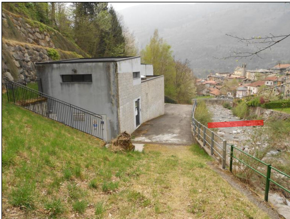
Figura 3: tratto interessato dall'opera di presa delle acque al torrente Remulo dell'impianto in progetto.
